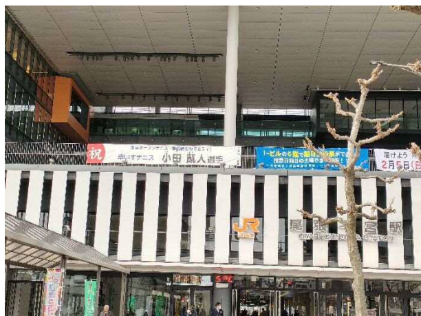
▼i-ビル 3階シビックテラス
